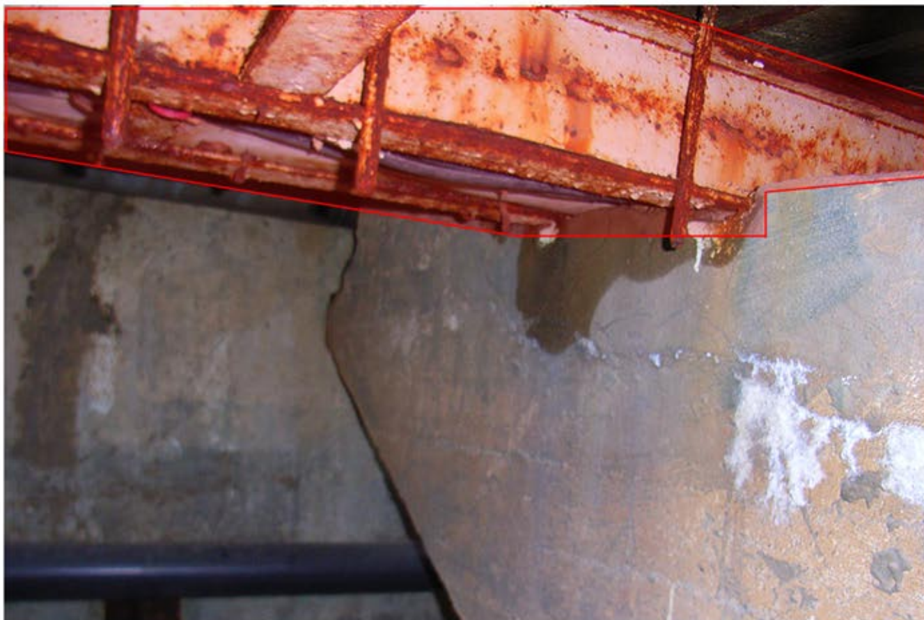
vymeniť skorodované, nosné, železné profily a spojky a súčasti
